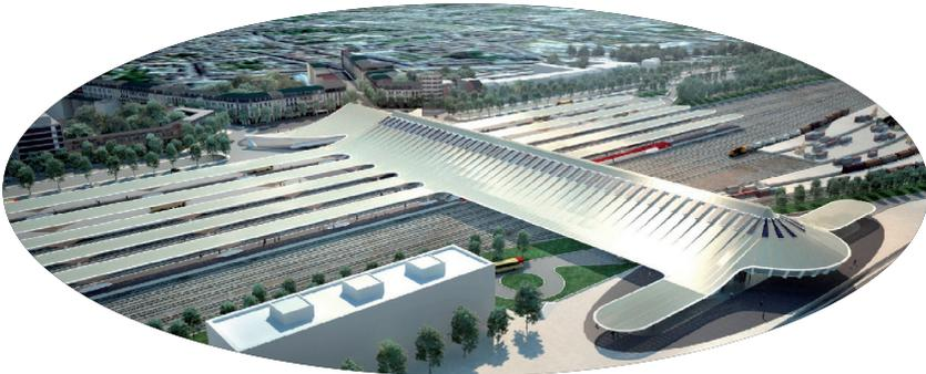
Les **matériaux** employés sont limités à cinq: le **béton blanc**, l'**acier**, le **verre**, la **Pierre naturelle** et le **bois**. Des panneaux photovoltaïques mobiles seront placés sur la toiture.
